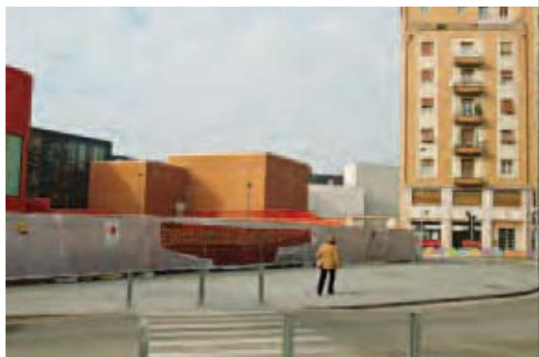
testo della zona della città e sono pannellature in cemento armato prefabbricate con inserimento in matrice di mattoni a vista, il resto è realizzato in calcestruzzo addizionato di pigmento bianco.
