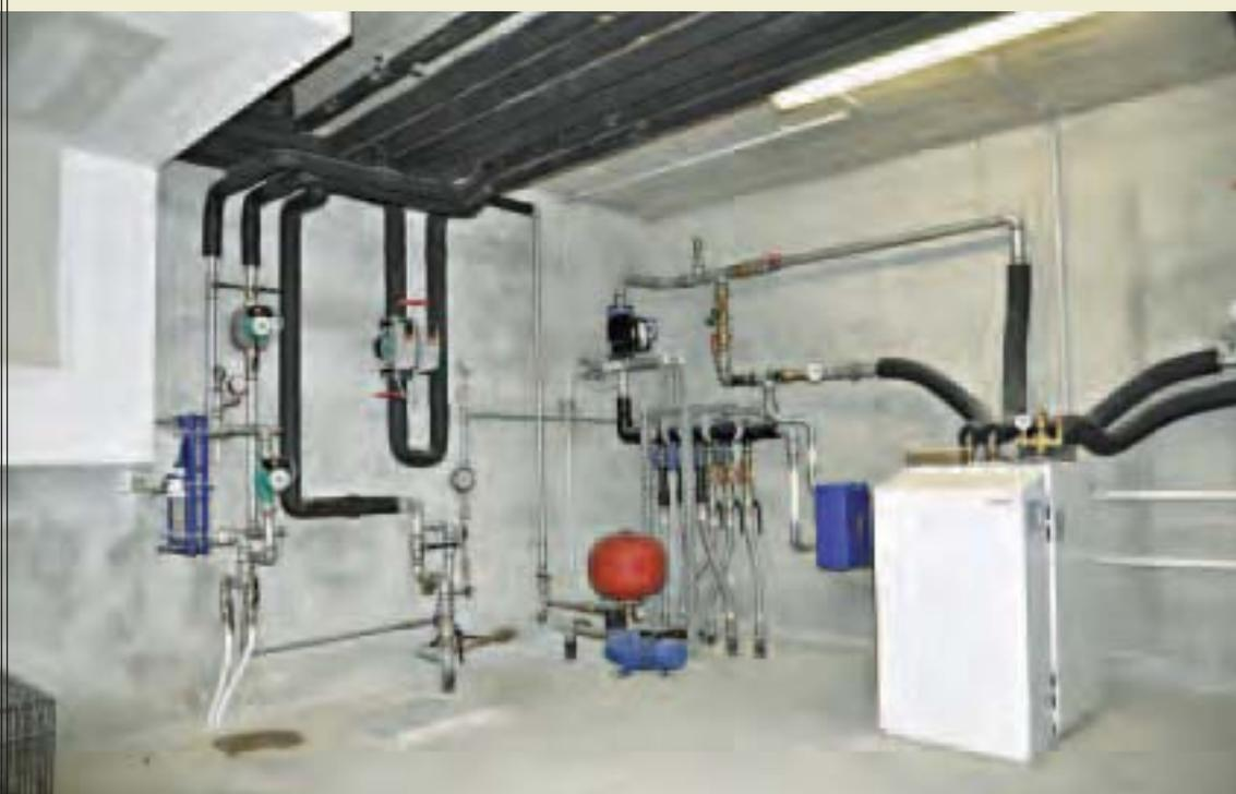
*Sopra: altro settore della centrale termica: a sinistra la pompa di calore, al centro i due "puffer", rispettivamente per l'accumulo di acqua calda per il riscaldamento e per l'acqua calda sanitaria; all'estrema destra (semivisibile) l'addolcitore dell'acqua.
