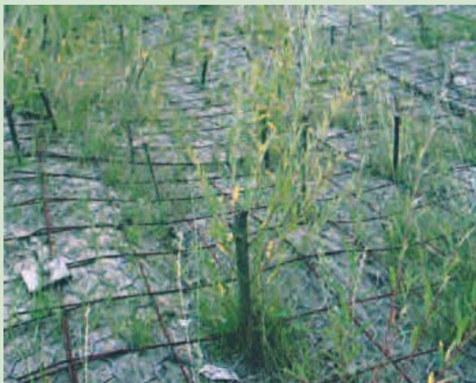
anche in considerazione del rischio di contatto delle pale in rotazione. La rete, al contrario delle altre opere di ingegneria naturalistica, non trattiene la terra fine e quindi l'acqua, evitando i rigonfiamenti ed i crolli per sovrappeso delle strutture in legname.
