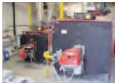
Le caldaie a condensazione sono le caldaie più moderne ed ecologiche oggi esistenti. Riescono infatti ad ottenere rendimenti molto elevati grazie al recupero del calore latente di condensazione del vapore acqueo contenuto nei fumi,
